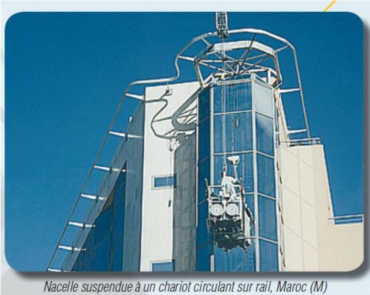
*Nacelle suspendue à un chariot circulant sur rail, Maroc (M)*
