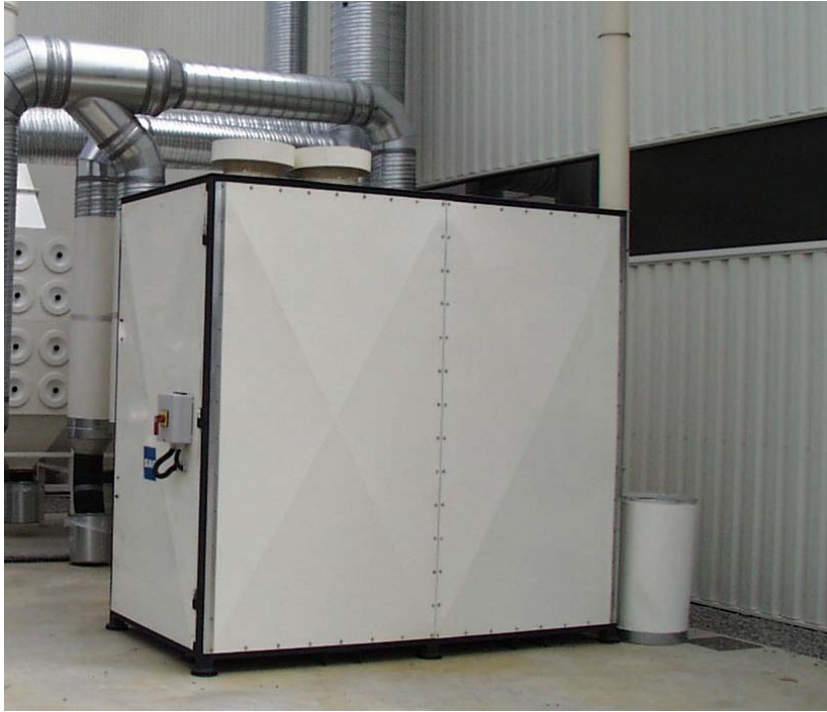
CENTRALE 4500 M3/H Installation extérieure, mise en service et contrôle électrique intérieure usine. Aspiration pour 30 torches aspirantes
