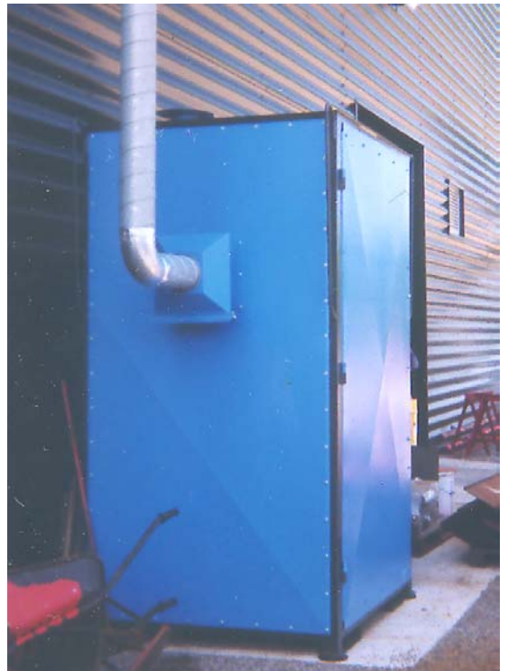
CENTRALE 3000M3/H Sans Filtration Aspiration pour 15 soudeurs
